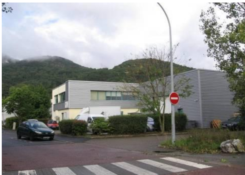
Vue depuis la rue Valérien Perrin (angle sud Est)
